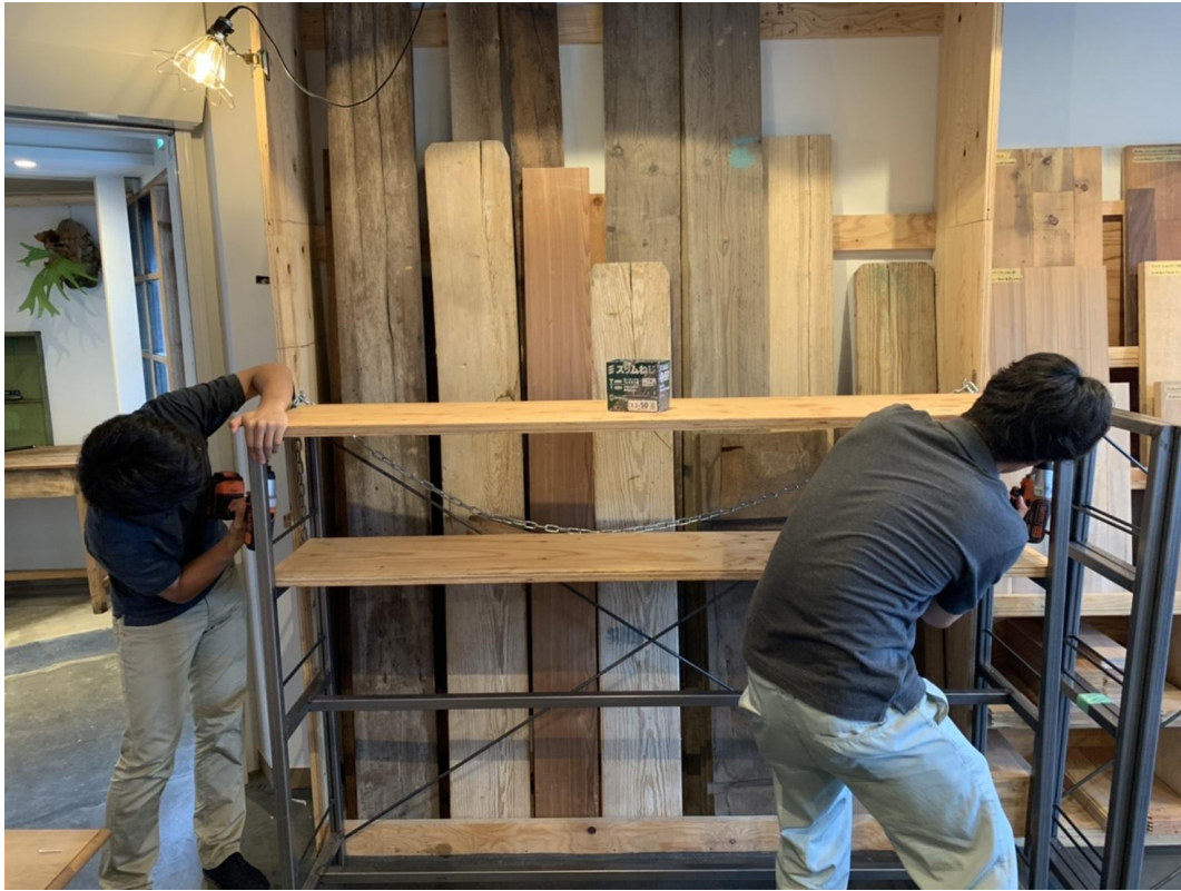
アイアンの枠は鉄骨屋さんに依頼 届いた屋久杉を打ちつける
